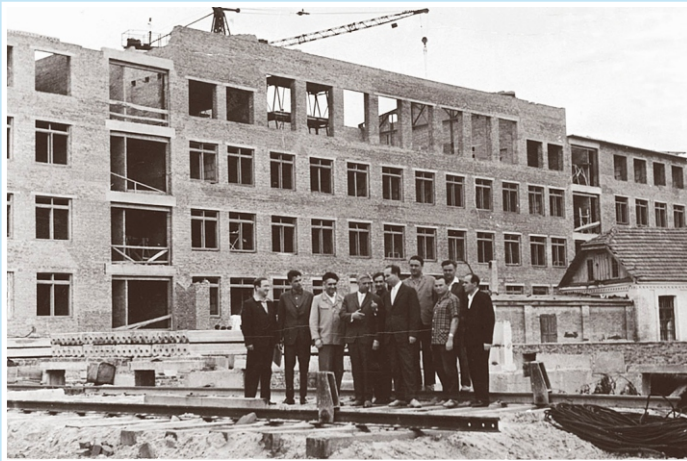
Будівництво ПМСІ (60-ті роки) Construction building of PMSI (60s)
